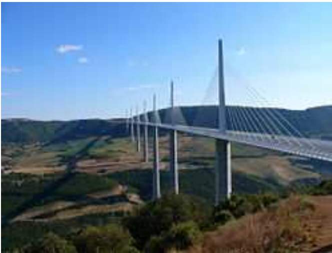
Viaduc de Millau
