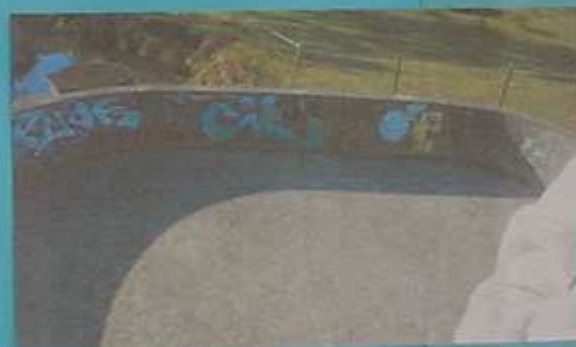
Bassin de rétention d'eau (zone de stockage des eaux de crue)
