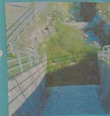
Rampe d'évacuation d'eau asséchée (niveau du GALOPIO normal)
