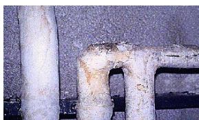
Calorifugeage de tuyaux
