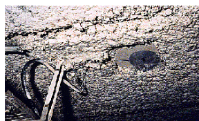
Flocage de plafond
