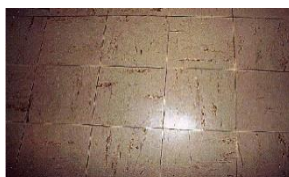
Dalles de sol
