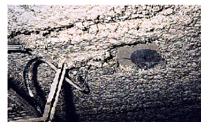
Flocage de plafond
