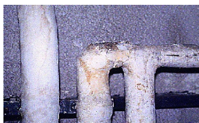
Calorifugeage de tuyaux
