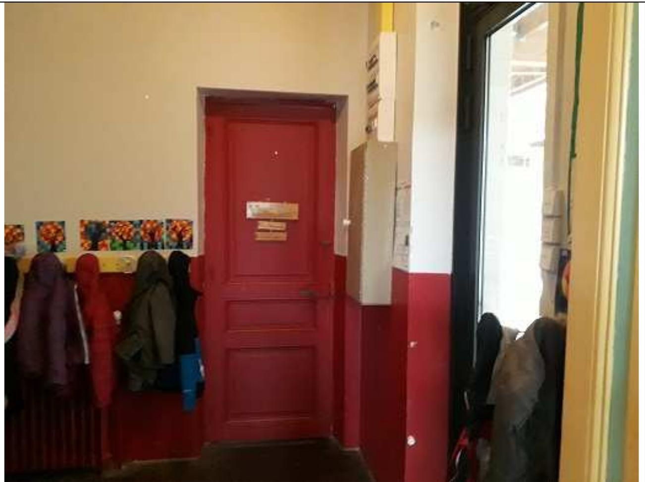
L'article PE 24 ne fait pas mention des tableaux électriques mais des locaux renfermant des matériels électriques dont l'accès est réservé. Il ne s'agit pas ici d'un local mais d'un tableau dans un lieu de passage.
