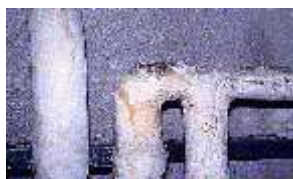
Calorifugeage de tuyaux
