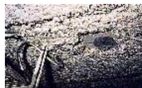
Flocage de plafond
